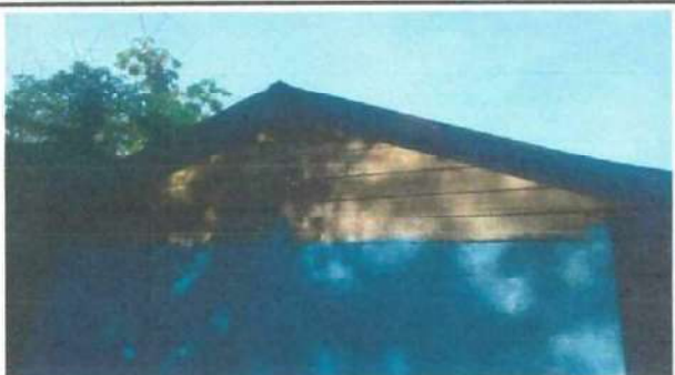
Foto 3: Cerrar con blok la parte de arriba
