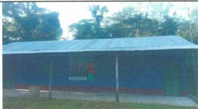
Foto1: Cambio de techo del Establecimiento.
