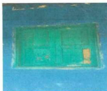
Foto 6: Cambiar venta a metal tipo balcones.
