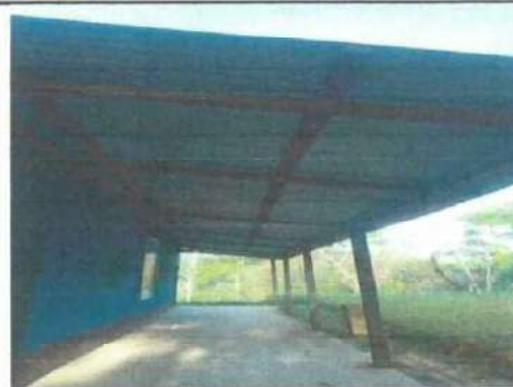
Foto 2: Cambio de las vigas y costaneras.
